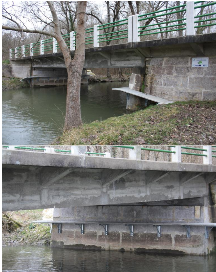
Pont de Beaulieu
