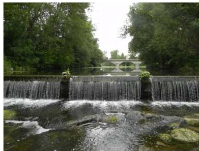
L'ouvrage du Pérat avant travaux
