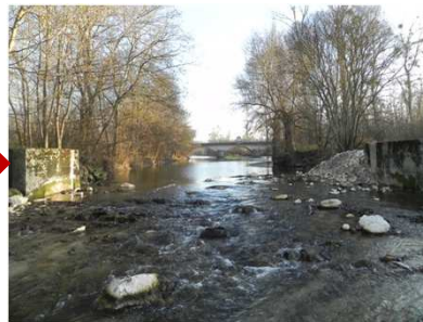
L'ouvrage du Pérat après travaux
