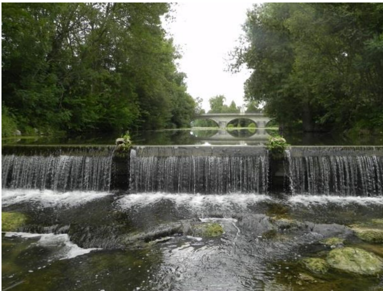
L'ouvrage du Pérat avant travaux
