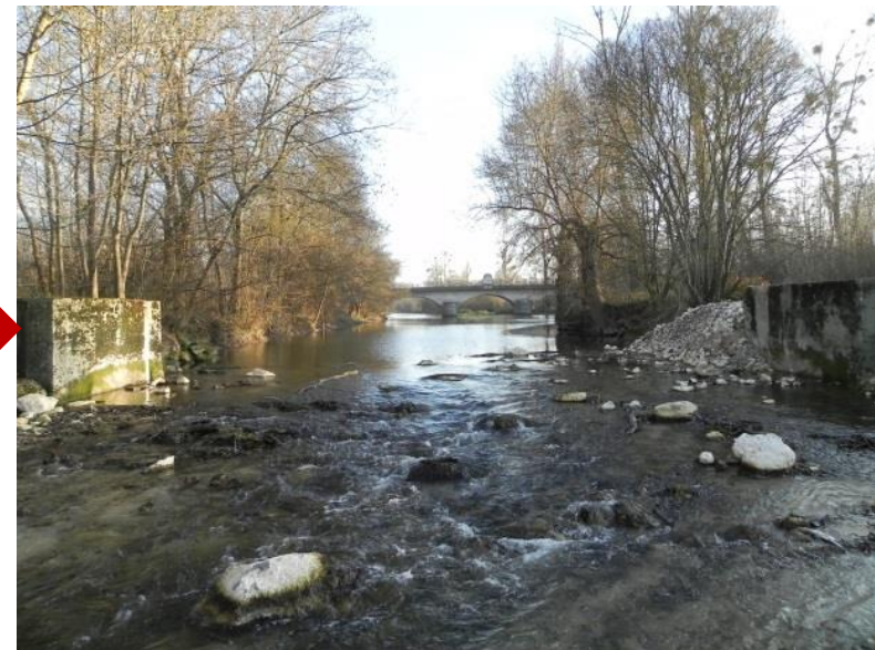
L'ouvrage du Pérat après travaux
